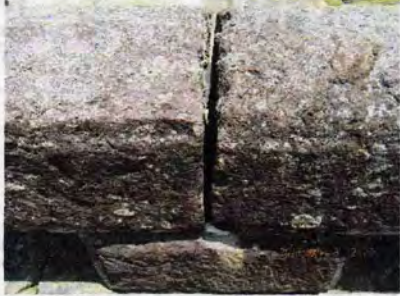
二俣福良渡(小筵)町指定 岸の壁石崩落。輪石は残存。 通行禁止。
