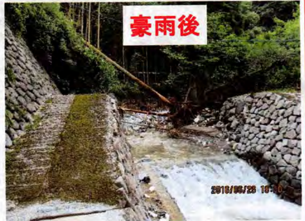
石橋完全流失。流木が流れた形跡在り。下流域田んぼに大量の土砂流入あり。
