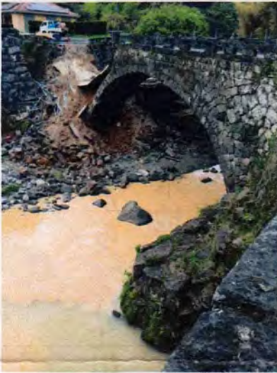
二俣福良渡(小筵)町指定 岸の壁石崩落。輪石は残存。 通行禁止。
