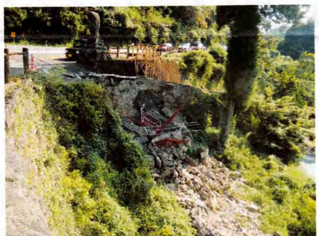
霊台橋(美里町清水)国指定 付帯施設が崖からの多量の水によって崩れ去る。霊台橋へも水が流れる。
